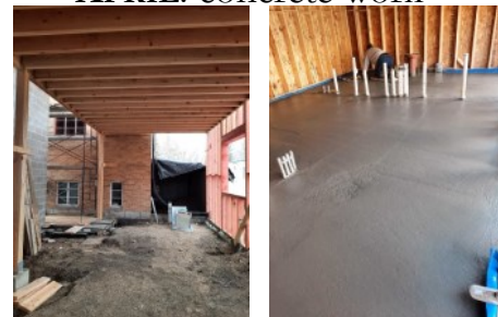
APRIL: concrete work
