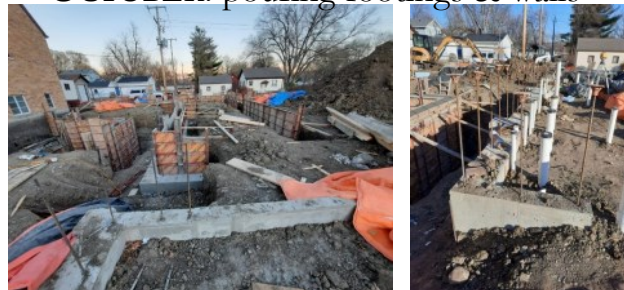
OCTOBER: pouring footings & walls
